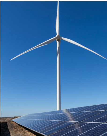
Instalação da central elétrica híbrida de El Conilete.
