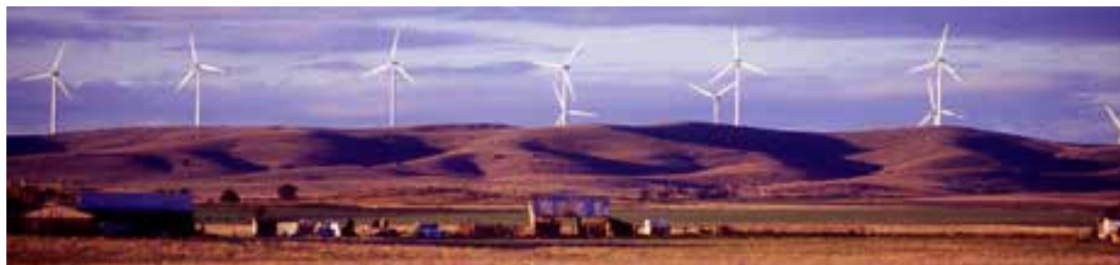
Parque Eólico Blue Canyon, EEUU
