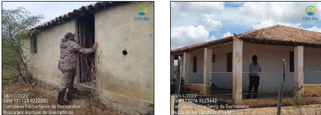
Figura 3.191: Técnico realizando vistoria em possíveis abrigos de quirópteros na área de influência do Complexo Eólico Serra da Borborema.
