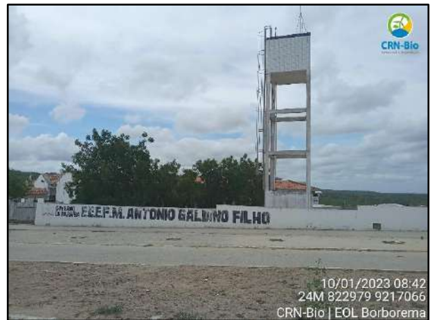
Figura 3.260: Escola Estadual Antônio Galdino Filho. Fonte: CRN-Bio, 2023.
