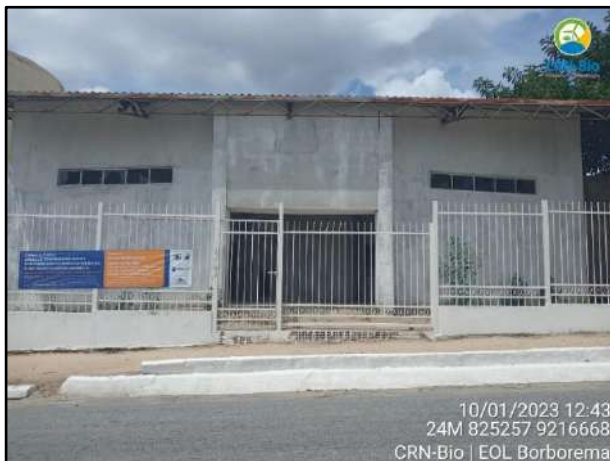
Figura 3.272: CTeatro Municipal (em construção), Pocinhos. Fonte: CRN-Bio, 2023.
